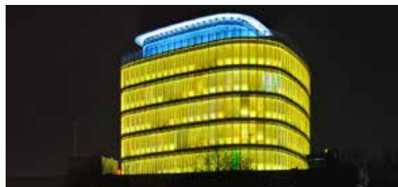
Großflächiger Stromausfall: Notstromversorgte Gebäude sollen den Bürgern als Anlaufstellen dienen.
