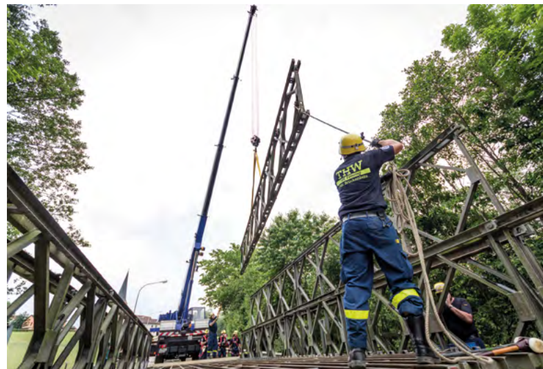
Mithilfe eines Ladekrans bauten THW-Einsatzkräfte im bayerischen Wittibreut eine D-Brücke über den Fatzöder Bach. Die Unwetter zum Sommerbeginn hatten die Fahrspuren so stark zerstört, dass die Straße nicht mehr befahrbar war. (Foto: Michael Matthes)
